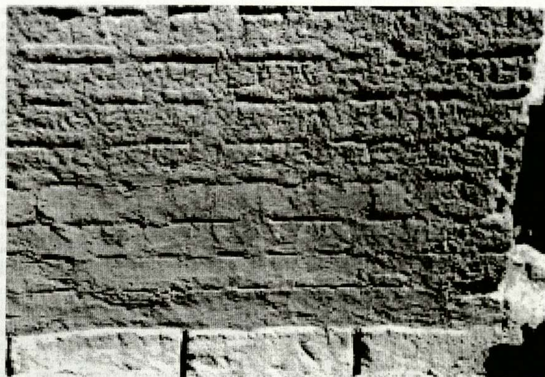
Рис. 127. "Замок" в Шахристане. "Пунктирная" кладка на западном фасаде.
